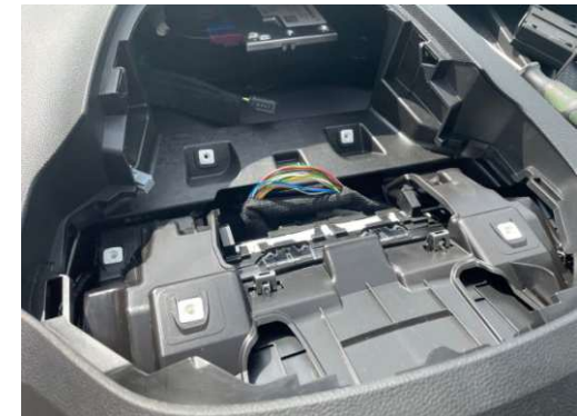
CAN Bus Kabel befinden sich im Kabelbaum hinter dem Kombiinstrument (Kabel sind verdreht) 6 Troxschrauben 20 in der Abdeckung über dem Kombiinstrument.
