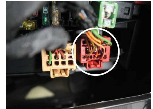
Roter Stecker unter Sicherungskasten (Immer von Kabelseite betrachtet)
